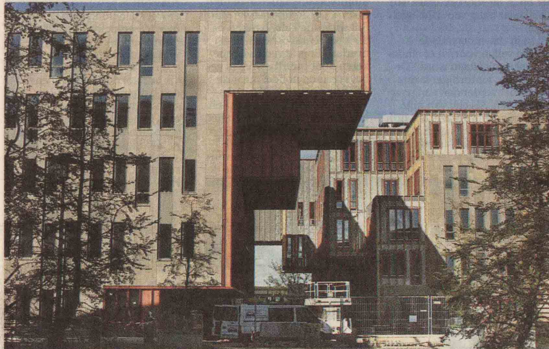
Een blik tussen de twee kantoorgebouwen van Tangram door, langs de hoofdas van het Arenapark. De kantoorwerkers van Aedes en Global Crossing hebben er vol zicht op. Foto: Ton Kastermans
