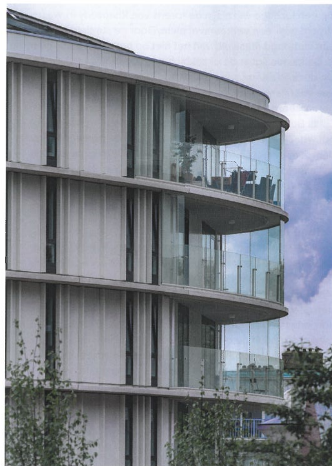
Voor geluidbelaste kozijnen met te openen ramen staan verdiepingshoge glazen schermen.
