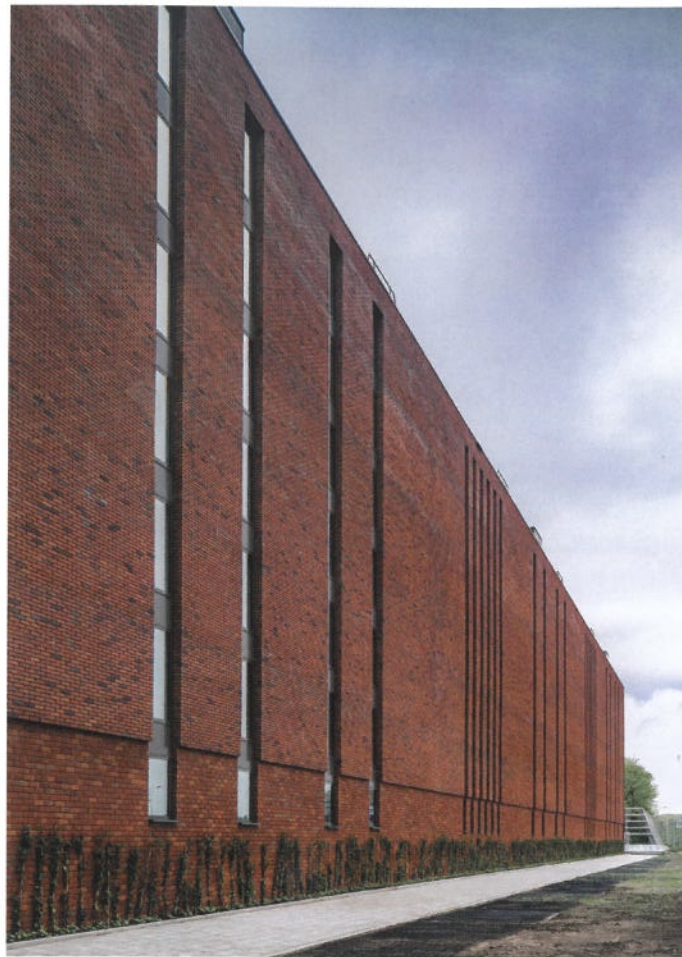
Een doof rugblok aan de zijde van de A10 weert het verkeerslawaai.
