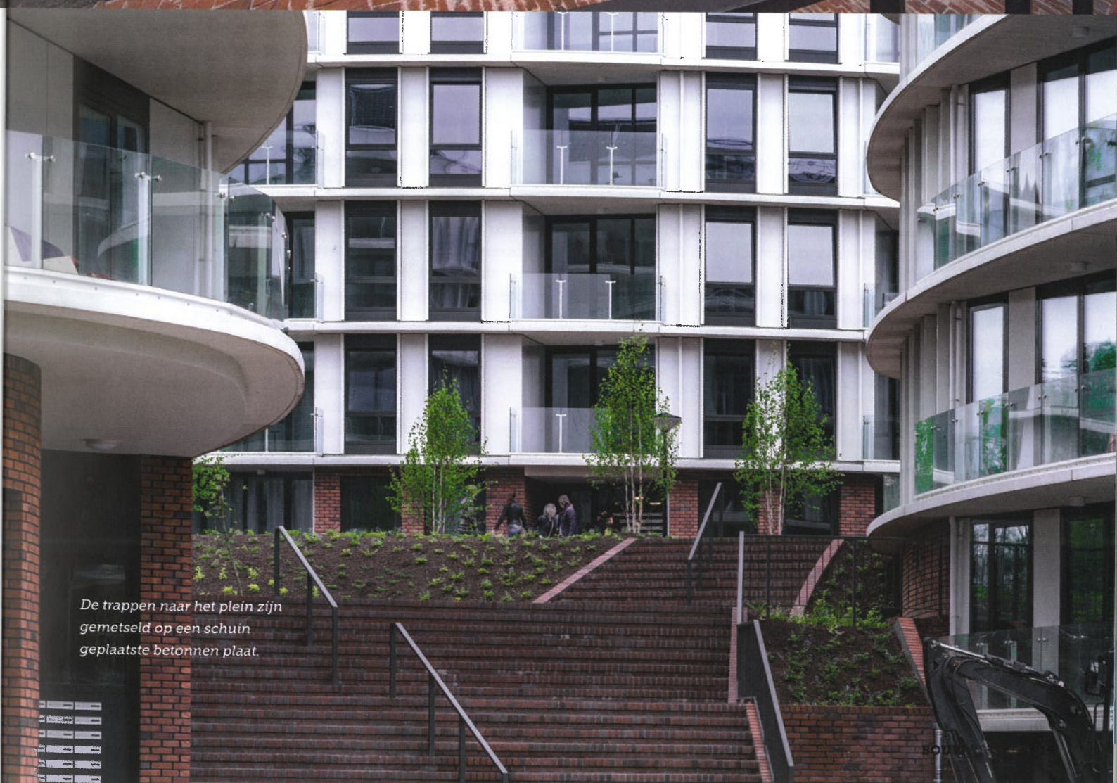
De krommingen van de torens en de golvende zijde van het A10-blok zijn gefacetteerd uitgevoerd met aluminium kokers tussen de rechte geveldelen.
