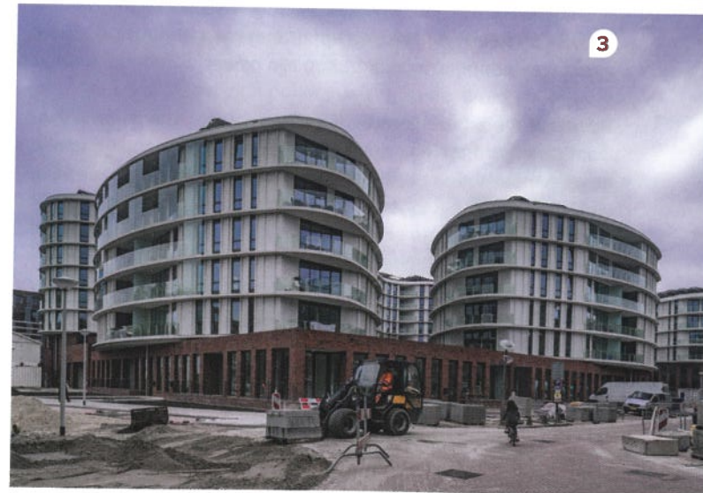
1 // Onder het verhoogde maaiveld ligt de tot 4,5 m hoge garage met een dragende schijvenstructuur. 2 // De frames met de zonnepanelen zijn opgetild boven het dakvlak in verband met de installatiekast van de collectieve WTW installatie. 3 // Aan het Jan van Schaffelaarplantsoen loopt onder de torens een bakstenen plint met voorzieningen.
