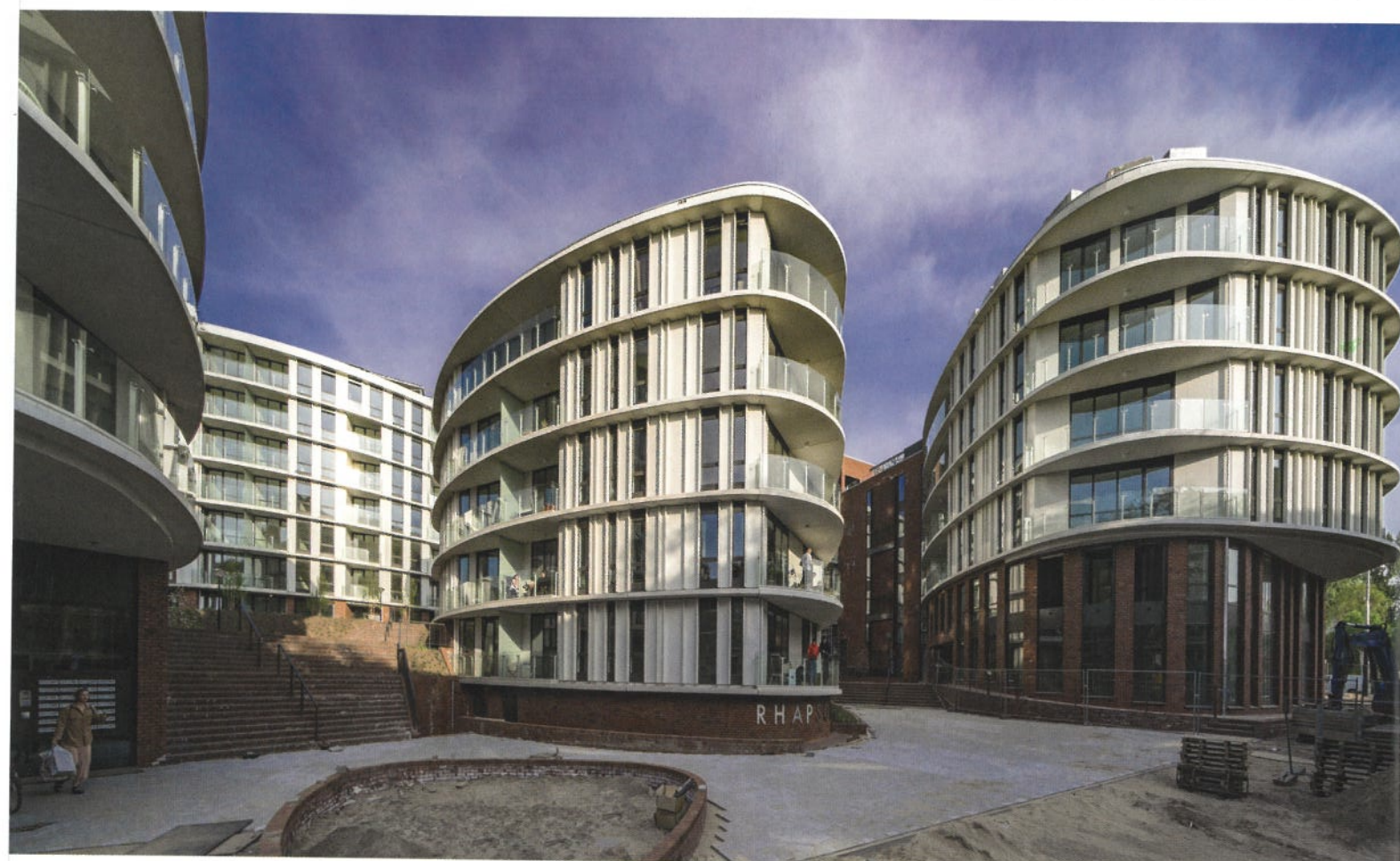
De krommingen van de torens en de golvende zijde van het A10-blok zijn gefacetteerd uitgevoerd met aluminium kokers tussen de rechte geveldelen.
