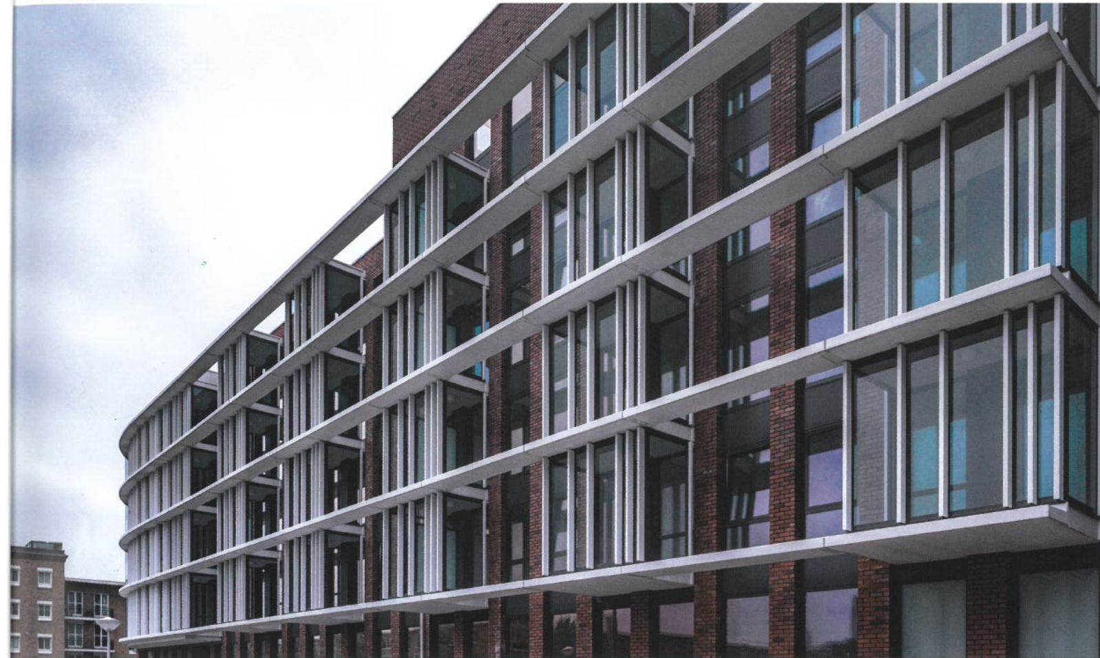
Aan de Bos en Lommerweg weren glazen loggia's met vast glas het geluid.
