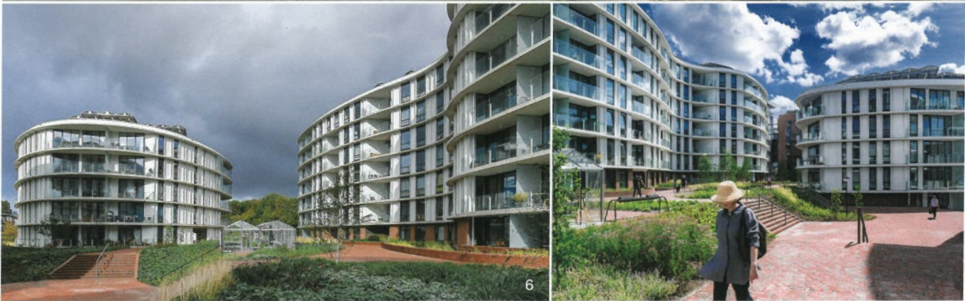
5. 面向社區主要道路的南立面是紅磚隔牆與社區內部白色立面的過渡帶。底層設有 400 平方公尺的鄰里大客廳。在這個共享空間中，鄰居們平日一飪聚會、聊天說笑，並經常舉辦團體活動。攝影：meijeske fotografie 6. 社區內立面全為圓弧造型，不僅為公共空間的流動與優美感加分，更是減低高速公路噪音的利器！攝影：meijeske fotografie 7. 高低起伏的庭園空間，為公共空間增添許多趣味。攝影：John Lewis Marshall 8. 住宅區內 5 座建築中上方 3 座一體的長形建築面向首都高速公路，圖中右方的 L 字形建築面向社區主要道路，另外 3 座圓弧形建築位於庭園內。公共空間中央是居民共享的溫室。版權：TANGRAM architecture and urban landscape
