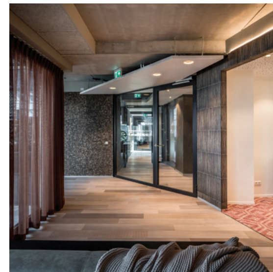
Dempende wanden, akoestische panelen en plafonds (Zuidoever, Amsterdam, Tangram)
